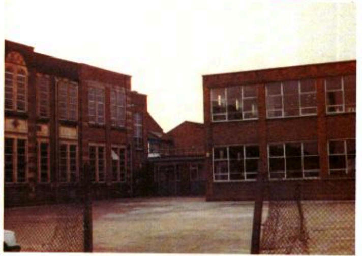
المبنى الجديد للمدرسة
