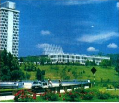
■ مبنى البرلمان في ماليزيا
