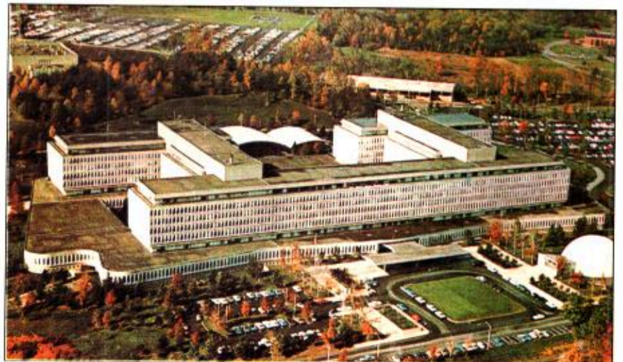
مبنى وكالة المخابرات المركزية
